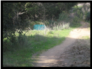
12. Manhole #89 32° 48.17 N 117° 11.35 W
