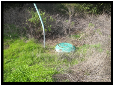
10. Manhole #92 32° 48.10 N 117° 11.31 W
