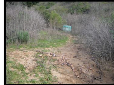
18. Manhole #159 32° 48.33 N 117° 11.41 W
