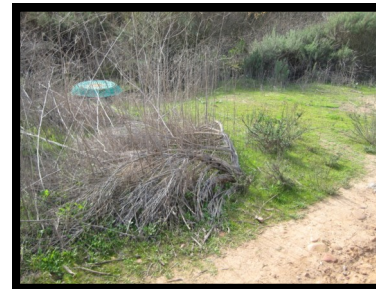
19. Manhole #269 32° 48.34 N 117° 11.43 W
