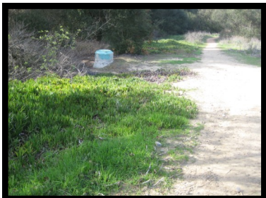
14. Manhole #178 32° 48.23 N 117° 11.36 W
