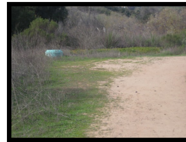
15. Manhole #176 32° 48.25 N 117° 11.38 W
