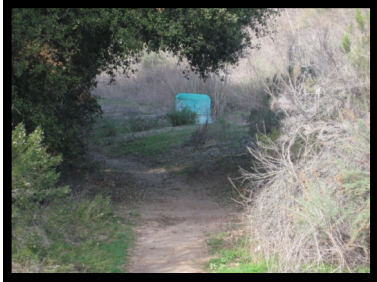
11. Manhole #90 32° 48.13 N 117° 11.33 W
